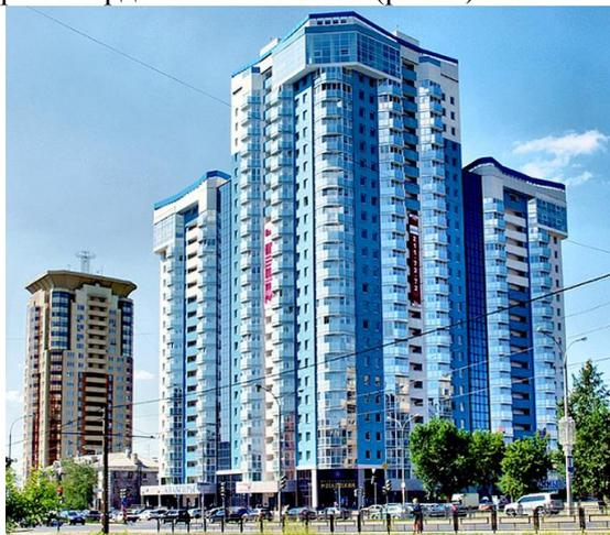
Рис. 3. 25-ти этажный современный жилой комплекс «Московский» в Екатеринбурге, построенного на основе металлокаркаса
