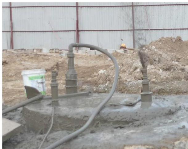
Рис. 10. Нагнетание раствора тонкодисперсного вяжущего вещества под давлением в нижнюю часть буронабивной сваи
